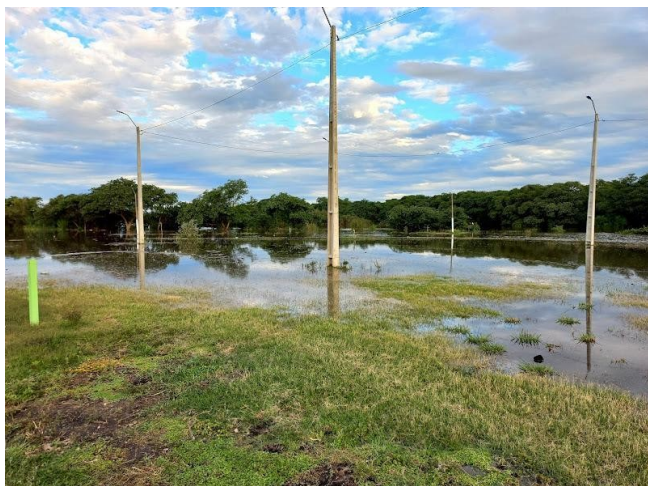
Fig. 3. Fotografía en la cual se aprecia el crecimiento de la Cañada Santa Rosa cubriendo una de las calles del Parque General Fructuoso Rivera.
